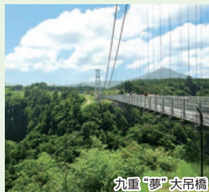
九重“夢”大吊橋
