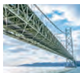
明石海峡大橋
