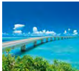
宮古島/伊良部大橋
