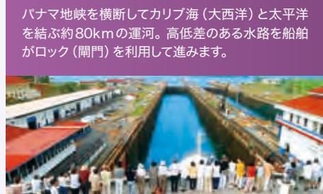
パナマ地峡を横断してカリブ海(大西洋)と太平洋を結ぶ約80kmの運河。高低差のある水路を船舶がロック(閘門)を利用して進みます。
