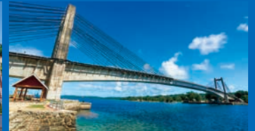
日本・パラオ友好の橋(パラオ)
